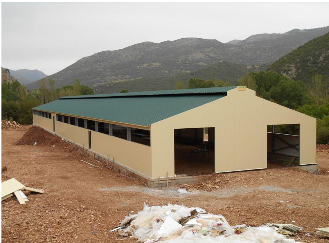
εικόνα: 29 Ποιμνιστάσιο (μεταλλική κατασκευή)
