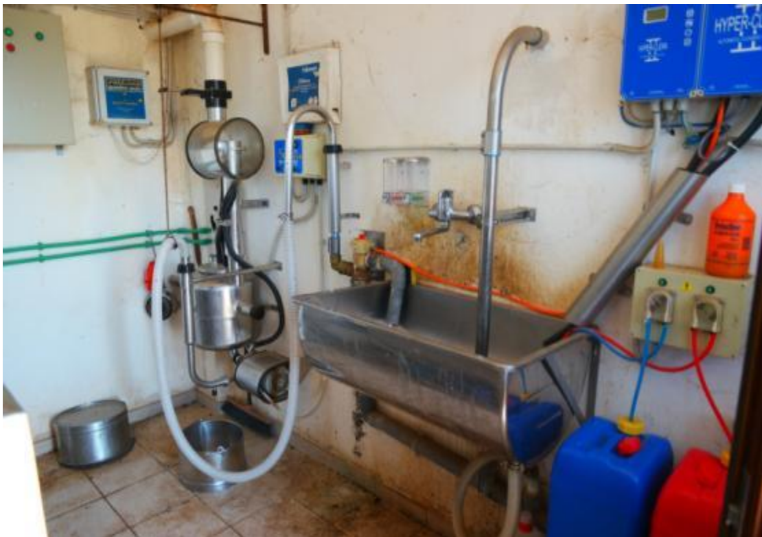
εικόνα: 66 Σύστημα μεταφοράς του γάλακτος από το αρμεκτήριο κατευθείαν στις παγολεκάνες
