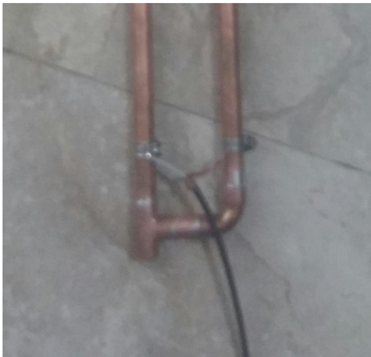
Εικόνα 43 Τοποθέτηση τροφοδοσίας στην κεραία
