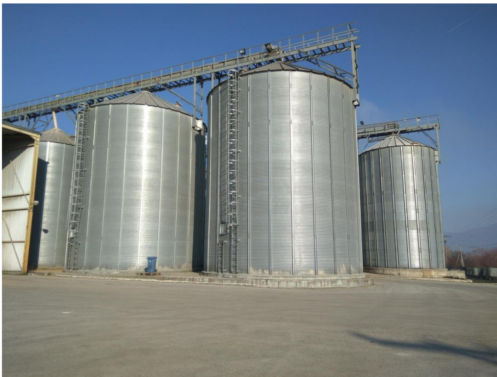
Εικόνα 5: Κάποια από τα εξωτερικά σιλό πρώτων υλών του εργοστασίου.
