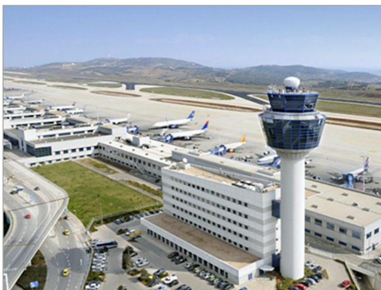
Εικόνα 2.4: Διεθνής Αερολιμένας Αθηνών
