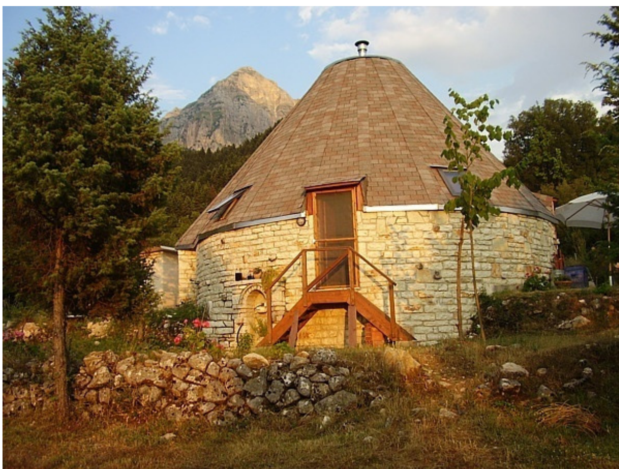
Εικόνα 5: Όψη μιας από τις κατοικίες του οικισμού «Θέασις».
