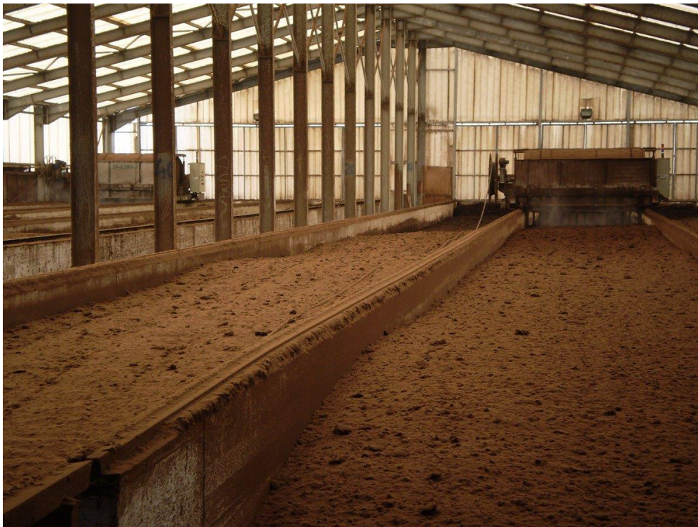
Τμήμα αερόβιας ζύμωσης και μετατροπή σε οργανικό λίπασμα
