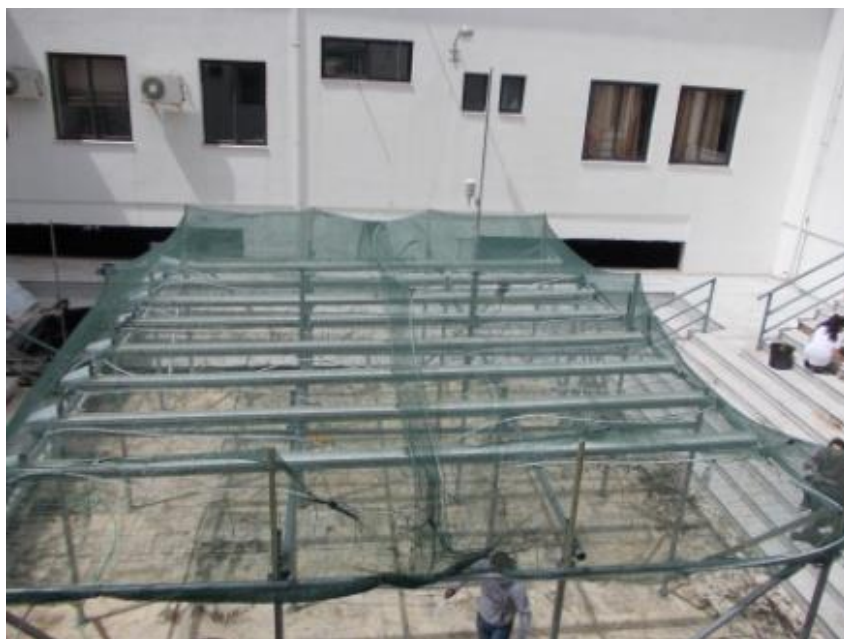
Εικόνα 61 Τοποθέτηση δικτύου σκίασης στην πέργκολα.
