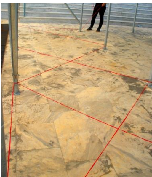
Εικόνα 62 Τοποθέτηση νήματος για να βρούμε το ακριβές σημείο φωτογράφισης.
