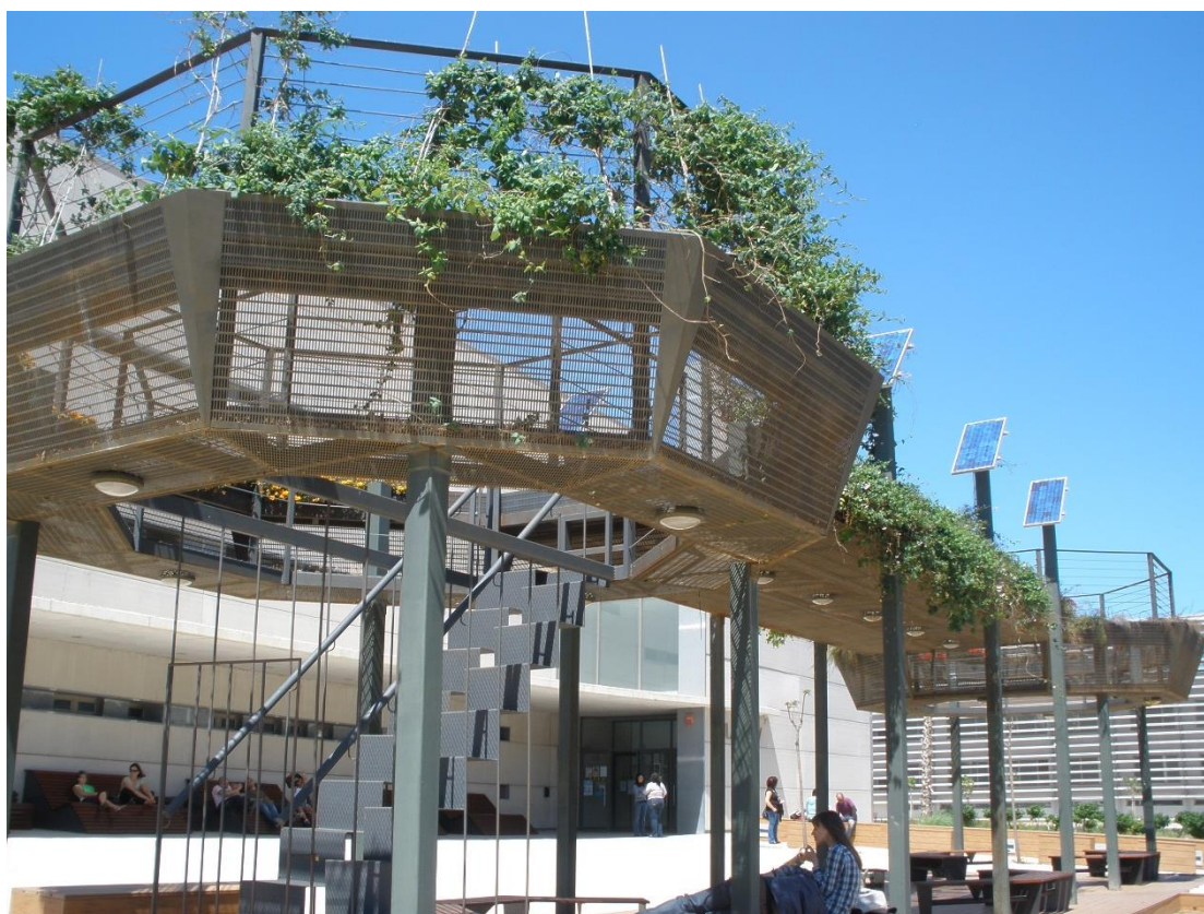
Εικόνα 9 Η υδροπονική πέργκολα που κατασκεύασαν οι Montero, Salas και Mellado στο Πανεπιστήμιο της Αλμερία (φωτογραφία: Ι. Λ. Τσιρογιάννης, 2011)
