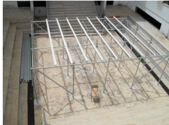
Εικόνα 28 Ολοκλήρωση κατασκευής του σκελετού της πέργολας
