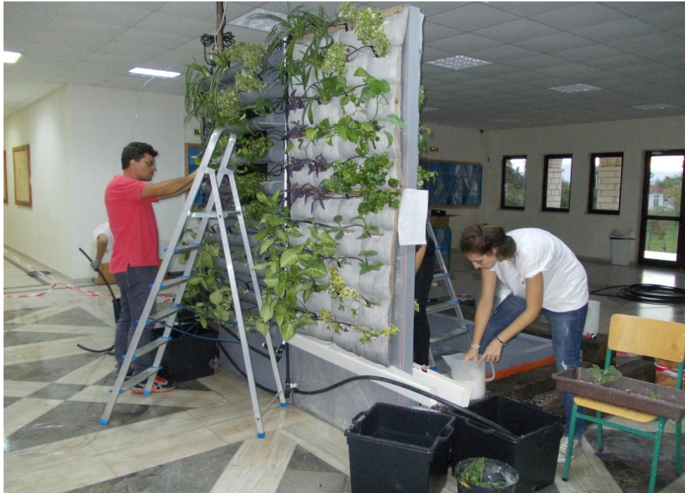
Εικόνα 21 Εργασίες στο σύστημα, έλεγχος αρδευτικού κ γέμισμα με περλίτη την μπροστινή πλευρά της τσόχας
