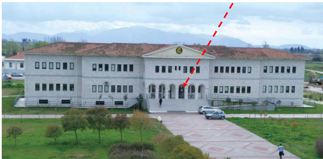
Εικόνα 10 Επάνω: δορυφορική εικόνα της Τεχνόπολης του ΤΕΙ Ηπείρου στους Κωστακιούς Άρτας (πηγή: GoogleEarth, 2014), κάτω: κύρια όψη κτηρίου ΑΑΤ
