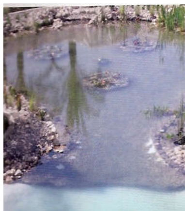
Εικόνα 55: Λίμνη κατασκευασμένη με σκυρόδεμα
