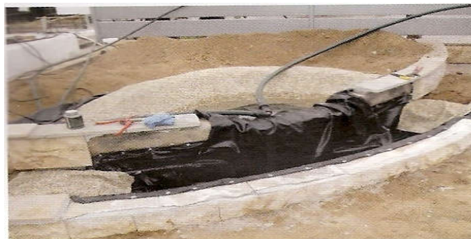
Εικόνα 56: Κατασκευή λίμνης από εύκαμπτα υλικά
