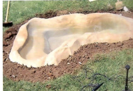
Εικόνα 57: Προκατασκευασμένη λίμνη από ημιάκαμπτα υλικά
