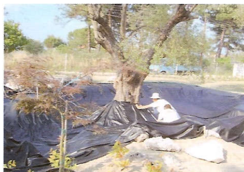
Εικόνα 72: Κατασκευή υδρόκηπου με ελαστικές μεμβράνες EPDM
