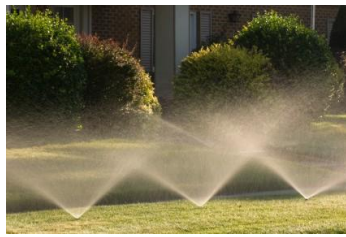
Εικόνα 3 Από αριστερά προς τα δεξιά: περιστροφικοί, στατικοί και πολυακτινικοί εκτοξευτήρες
