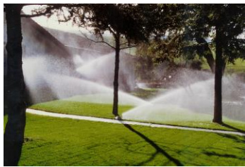
Εικόνα 3 Από αριστερά προς τα δεξιά: περιστροφικοί, στατικοί και πολυακτινικοί εκτοξευτήρες
