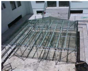
Εικόνα 55 Δίχτυ σκίασης τοποθετημένο στην πέργολα
