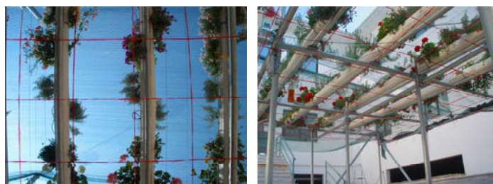
Εικόνα 62 Κόκκινο νήμα ακριβώς κάτω από τους φυτευτικούς φορείς
