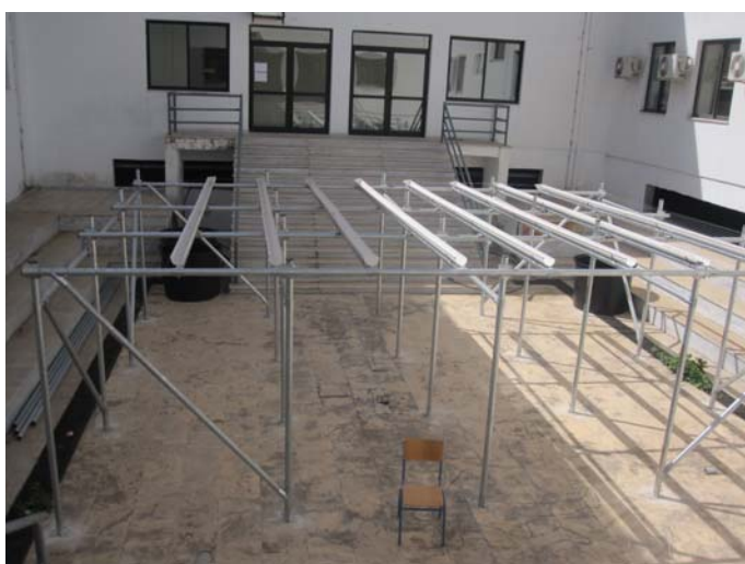
Εικόνα 10 Ολοκλήρωση κατασκευής του σκελετού της πέργολας
