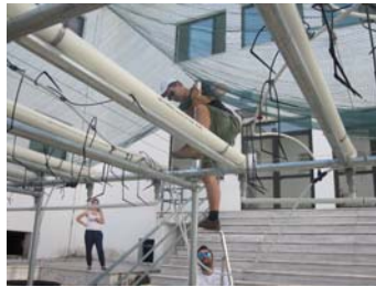
Εικόνα 54 Τοποθέτηση δικτύου σκίασης
