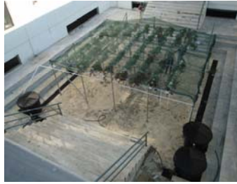
Εικόνα 58 Τέλος της τοποθέτησης των φυτευτικών φορέων στην πέργολα
