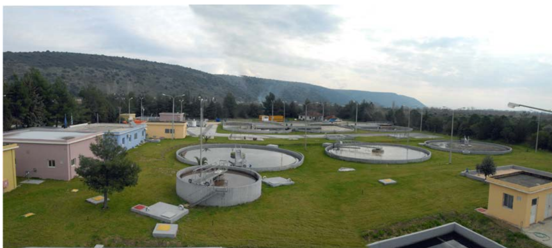
Εικόνα 12 Μονάδα επεξεργασίας λυμάτων Άρτας
