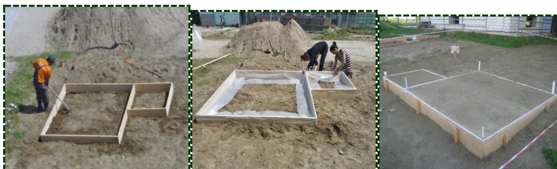
Εικόνα 18 : Στις παραπάνω φωτογραφίες απεικονίζεται η διαδικασία κατασκευής και γεμίσματος με άμμο του μικρού σποροδοχείου (Πανταζή Βασιλική, Άρτα 2014)
