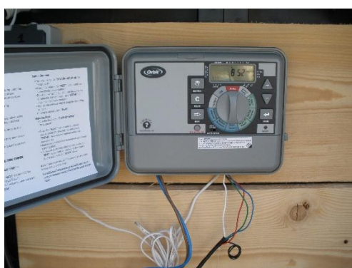
Εικόνα 17 α) Προγραμματιστής Orbit (εσωτερικός των 4 στάσεων και β) Αισθητήρας βροχής
