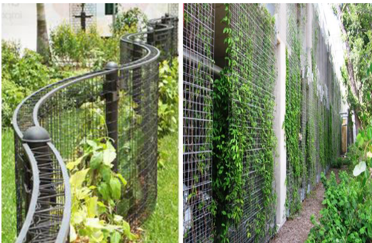
Εικόνα: 2.2.και 2.3. Σύστημα, Modular trellis panel system
