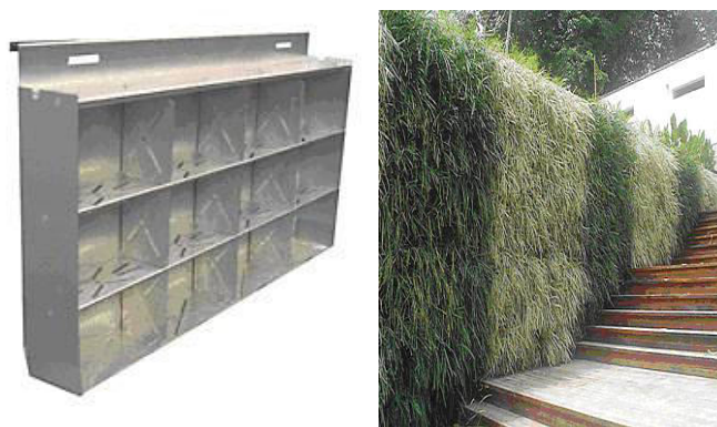
Εικόνα: 3.5. Ζωντανός τοίχος με ενότητες με ή χωρίς υπόστρωμα και φυτικό υλικό
