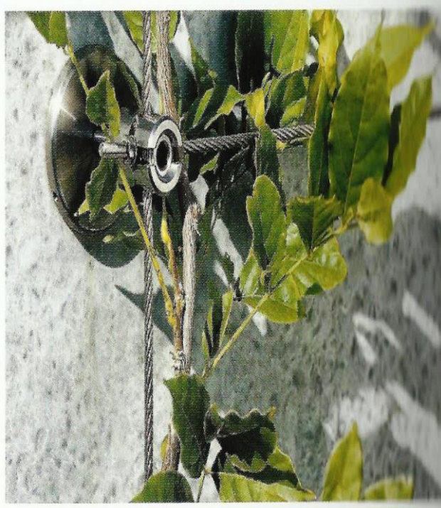
Εικόνα: 2.4. Πράσινη πρόσοψη τύπου “Cable wire – rope net system” Εικόνα: 2.5. Απεικόνιση σύνδεσης των υλικών
