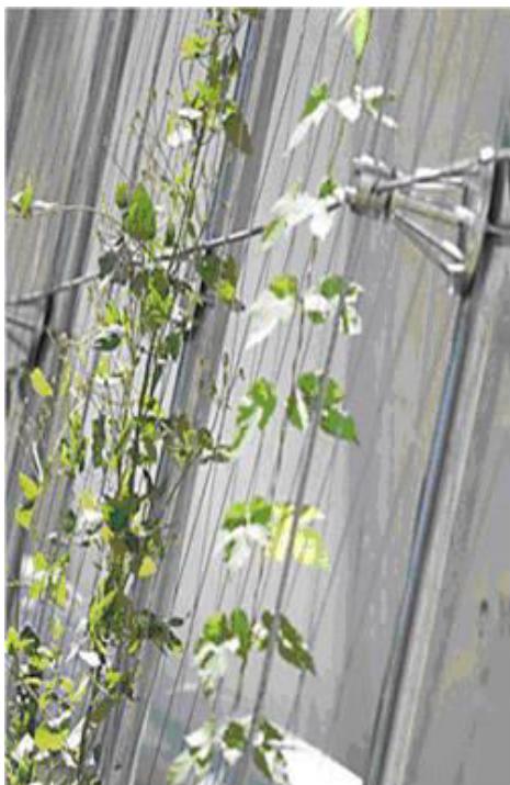
Εικόνα: 2.4. Πράσινη πρόσοψη τύπου “Cable wire – rope net system” Εικόνα: 2.5. Απεικόνιση σύνδεσης των υλικών
