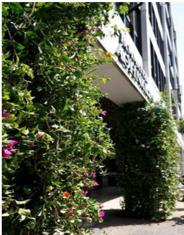
Εικόνα: 15.11. Κάθετη φύτευση στο εξωτερικό μέρος του κτηρίου της Γεν. Γραμματείας του Δήμου Αθηναίων στην οδό Λιοσίων.
