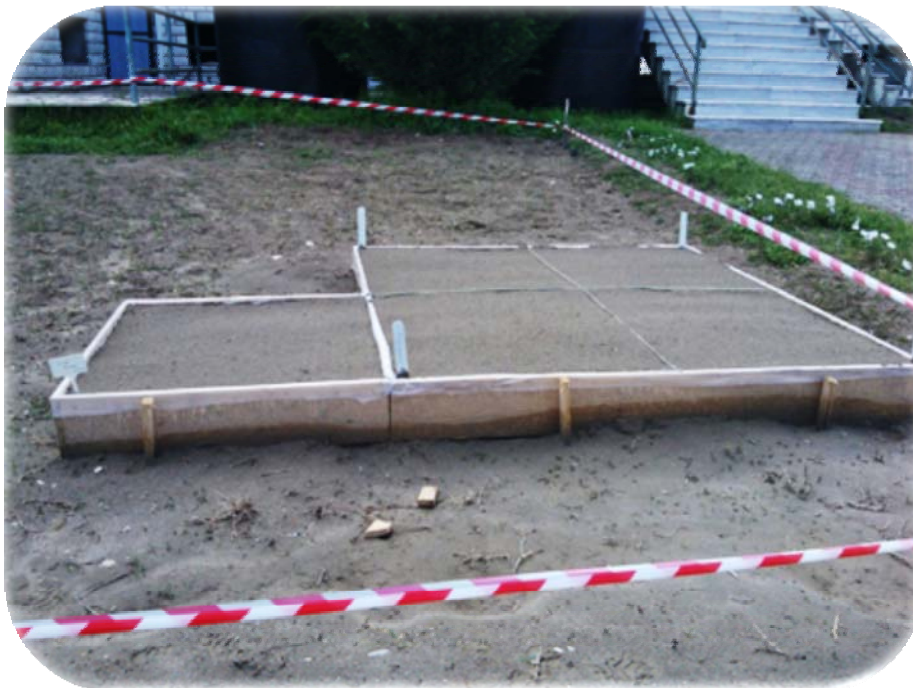
Εικόνα 16 Μικρό φυτοδοχείο (επάνω, την ημέρα της κατασκευής του, 3-4-14) και κάτω ολοκληρωμένο
