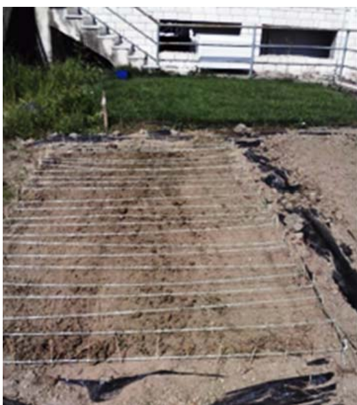
Εικόνα 22 Μετρήσεις για την μεταφύτευση στο πειραματικό τεμάχιο «Καρράς»
