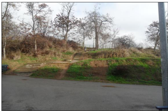
Εικ. 46 Πρανές Σιδηροδρομικού Σταθμού (Φωτογραφία : Ελένη Τζάπου)
