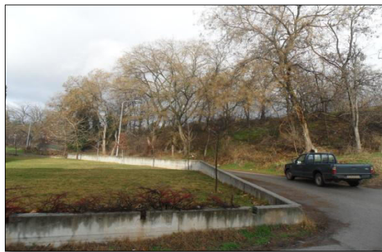
Εικ. 47 Πρανές Σιδηροδρομικού Σταθμού (Φωτογραφία : Ελένη Τζάπου)
