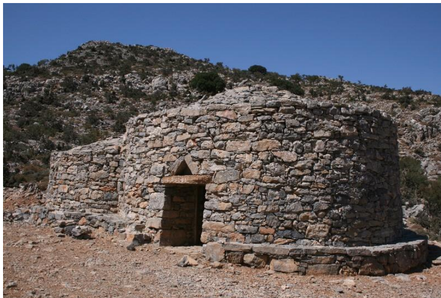
Εικόνα 36 : Μητάτο, Κρήτη [Πηγή: www.dpgr.gr ]
