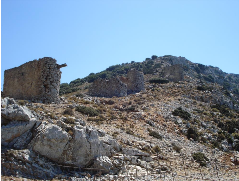
Εικόνα 7 : Κατεστραμμένοι Ανεμόμυλοι, Οροπέδιο Λασιθίου
