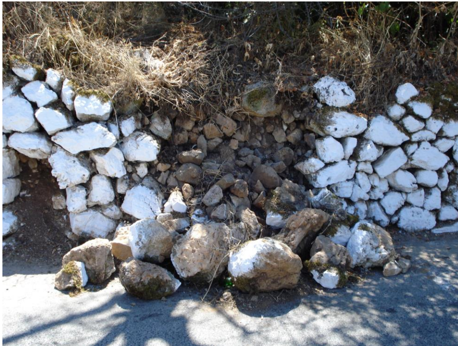
Εικόνα 26 : Ασπρισμένη – μισογκρεμισμένη ξερολιθιά, Κράσι Ηρακλείου
