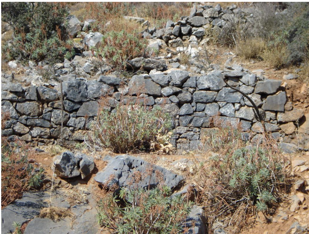
Εικόνα 21 : Ξερολιθιά που κάποια κομμάτια της παραμένουν σταθερά ενώ κάποια άλλα έχουν καταρρεύσει, Νικηφόρων Λασιθίου
