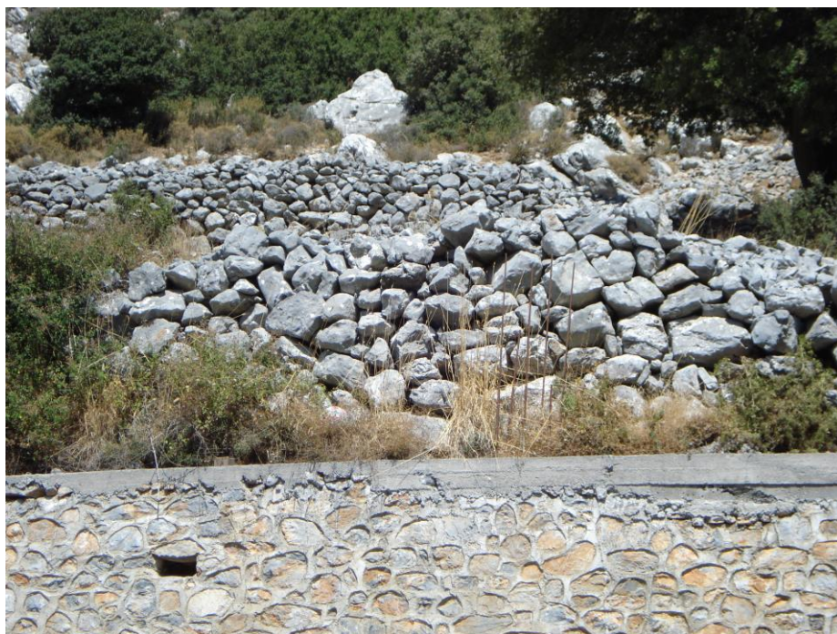
Εικόνα 28 : Αντιπαράθεση ξερολιθιάς (πάνω) και σύγχρονης κατασκευής με πέτρα και τσιμέντο
