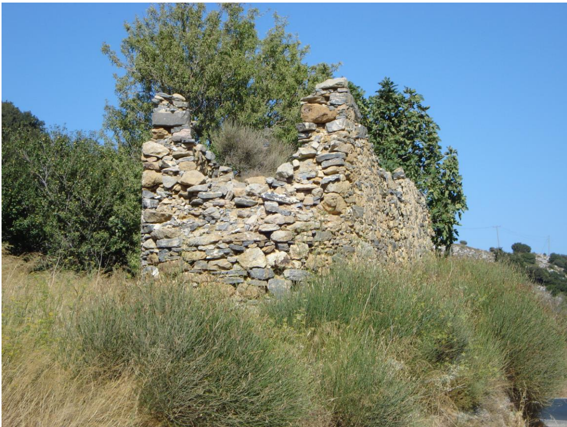
Εικόνα 6 : Κατεστραμμένος Ανεμόμυλος, Αργυρό Νερό Λασιθίου
