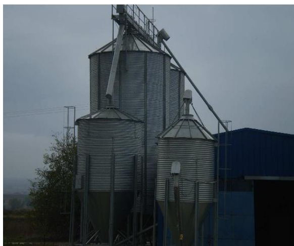
Εικόνα 11: Μεταλλικά σιλό αποθήκευσης ζωοτροφών
