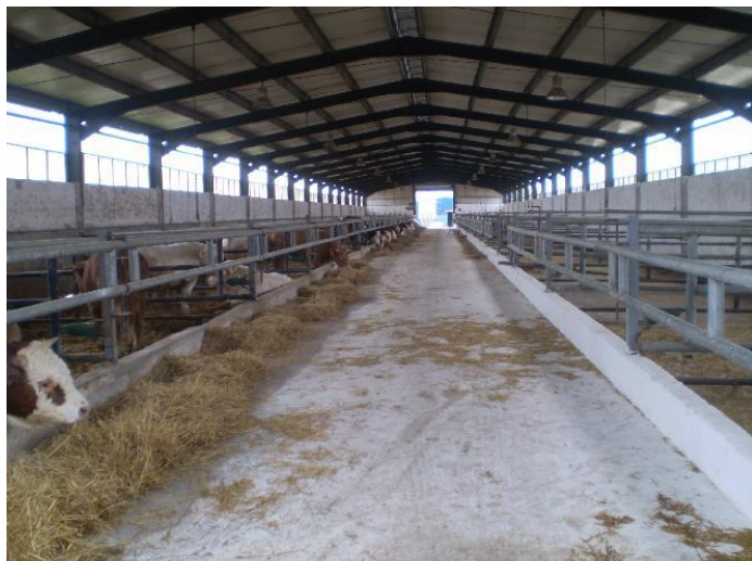
Εικόνα 6: Διάδρομος τροφοδοσίας σύγχρονου βουστασίου
