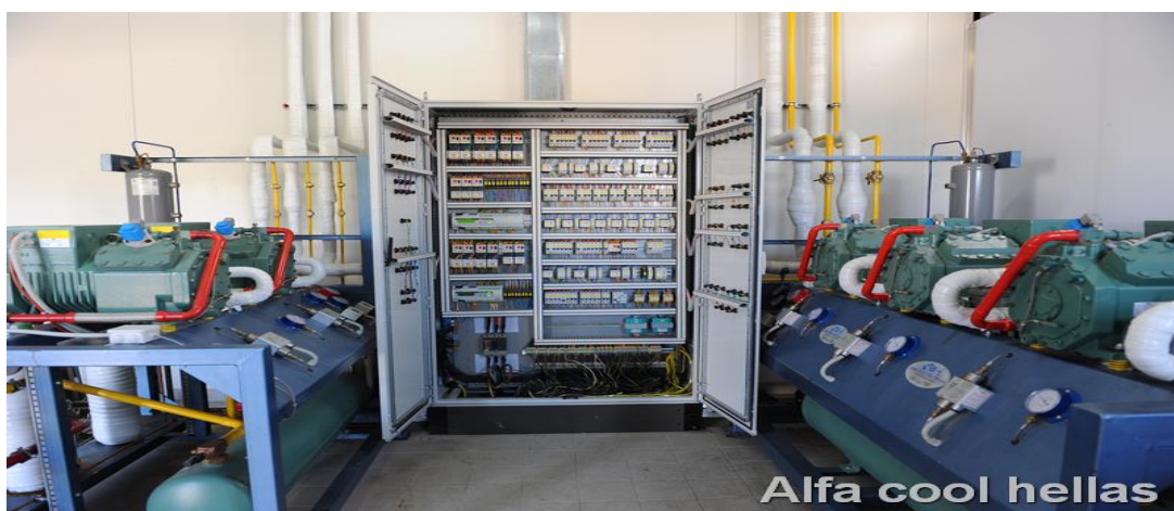
Γεννήτρια ρεύματος Ηλεκτρολογικός πίνακας
