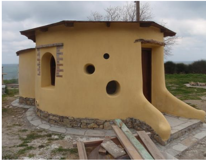
Εικόνα 10: Κατασκευή κτιρίου με πηλό.
