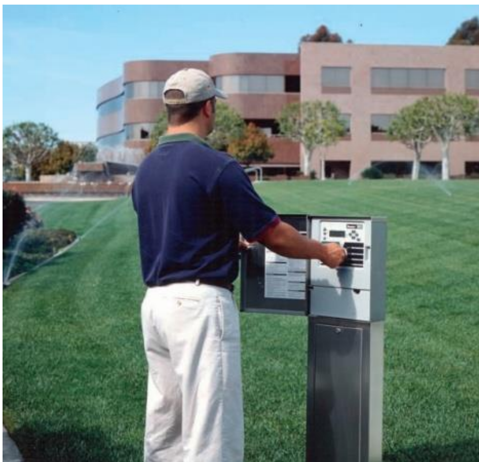
Εικόνα 2 Τοποθέτηση προγραμματιστή σε στεγανό κουτί
