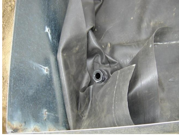
Εικόνα 32: Οπή για την απομάκρυνση του νερού της στράγγισης
