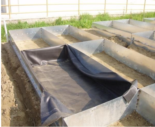
Εικόνα 31: Επένδυση με πλαστική μεμβράνη
