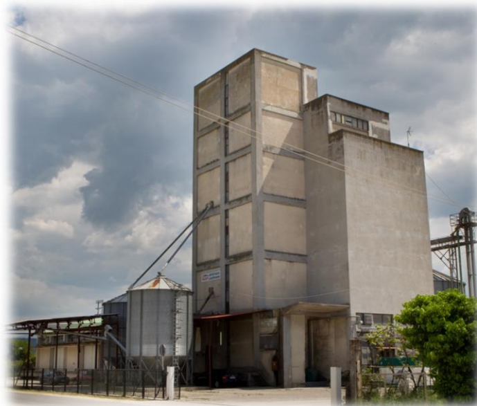
Εικ.34. Σύγχρονες ιδιόκτητες εγκαταστάσεις του Συνεταιρισμού εκκολαπτήρια, εργοστάσιο ζωοτροφών
