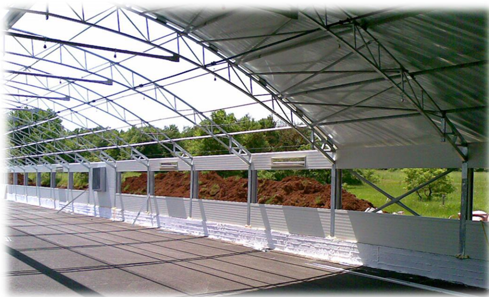
Εικ.2. Κατασκευή τοίχων και κρηπίδας (ΑΓΡΕΚ, 2015)
