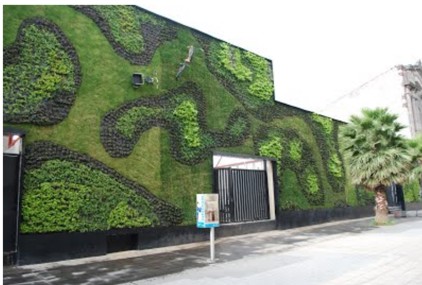
Εικόνα 6: Πρόσοψη κτιρίου με τύπο «Mat vegetated wall» (Πηγή: www.landscapeonline.com )
