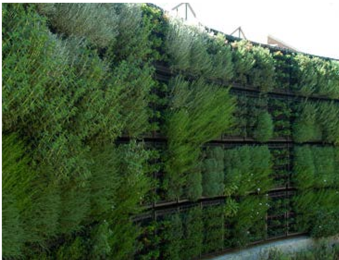
Εικόνα 8: Αρθρωτός κάθετος κήπος (Πηγή: www.tournesolsiteworks.com )
