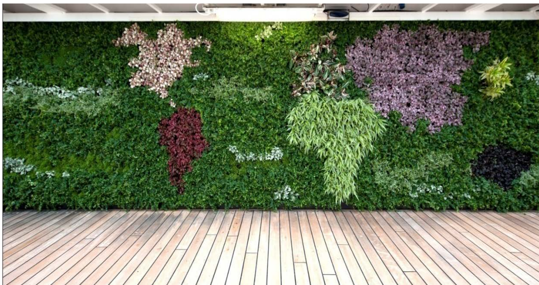
Εικόνα 5: Πρόσοψη τύπου «Living walls» (Πηγή: www.inhabitat.com )
