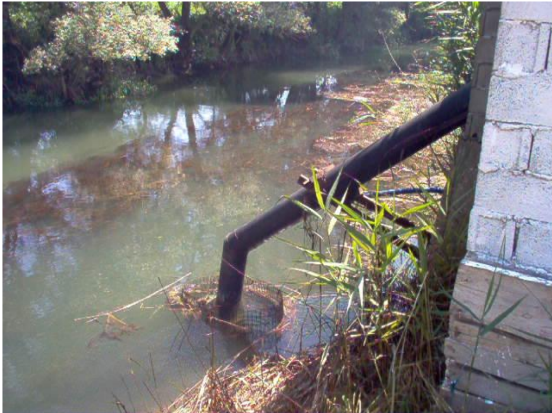
Εικ.9: Άντληση νερού.
