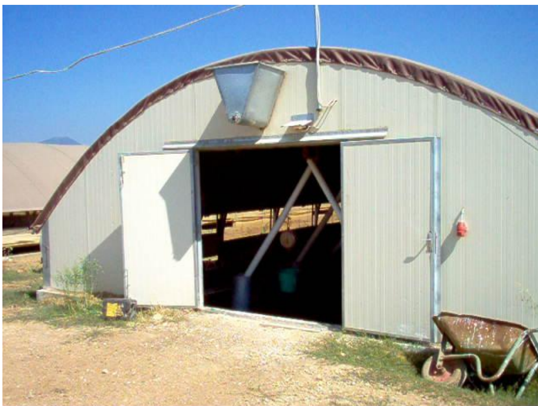
Εικ.20: Είσοδος toll.
