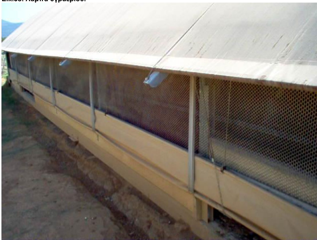
Εικ.39 : Άνοιγμα αερισμού. Διακρίνεται το προστατευτικό πλέγμα (σήτα) από PVC και η κουρτίνα από καμβά.
