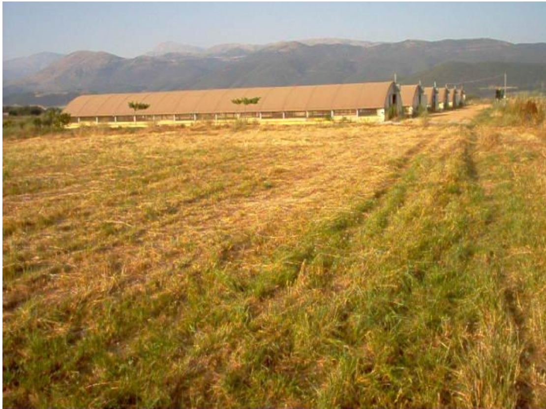
Εικ.18 : Συγκρότημα κτηρίων.
