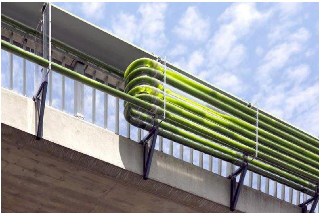
Εικόνα 21. Καλλιέργεια φυκιών σε γυάλινες ράβδους, οι οποίες είναι εγκατεστημένες πάνω σε αερογέφυρα
