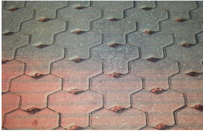
Εικ 37: Δάπεδο από κυβόλιθο και διάκενα αδρανούς υλικού 57
