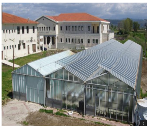
Εικόνα 127: Γυάλινο θερμοκήπιο υδροπονίας Δρ. Σάββας (πηγή: www.google.gr/maps )
