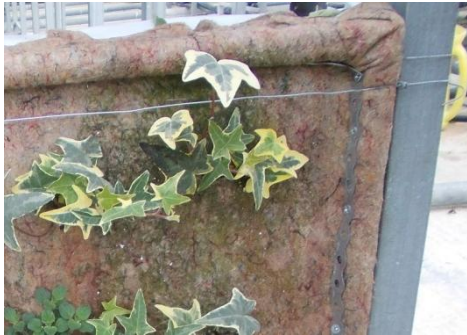
Εικόνα 142: Τοποθετημένο τσέρκι σε πάνελ για τη συγκράτηση του υδροπονικού περλίτη
