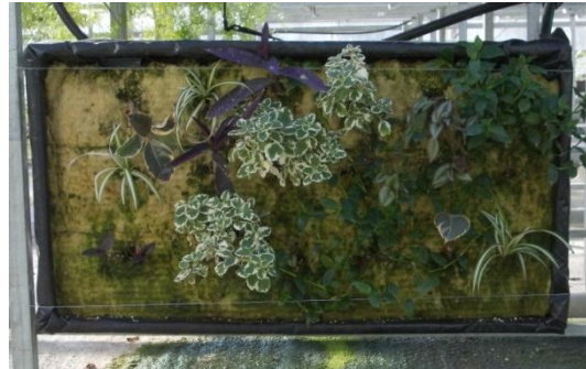
Εικόνα 143: Τοποθετημένα τούβλα πετροβάμβακα
