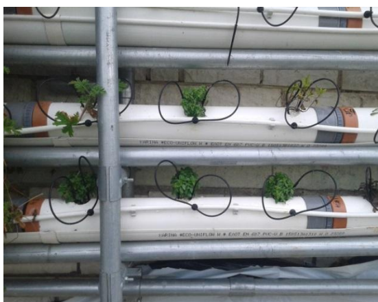
Εικόνα 140, Εικόνα 141: Τοποθέτηση φυτευτικών φορέων στον υδροπονικό κάθετο τοίχο
