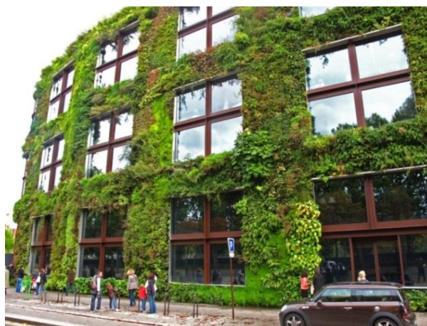
Εικόνα 8: Πρόσοψη κτιρίου με τύπο «Mat vegetated wall» (πηγή: www.verticalgardenpatrickblanc.com )
