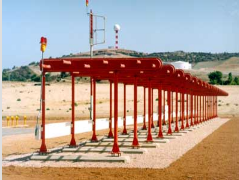
Εικόνα 3.1: Απεικόνιση συστήματος ενόργανης προσγείωσης ILS [1]
