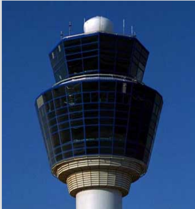
Εικόνα 4.4: Το Radome της κεραίας του ραντάρ κινήσεων επιφανείας στην κορυφή του Πύργου Ελέγχου [3]
