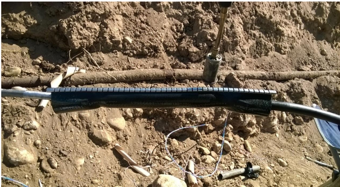
Εικόνα 53: Κόλληση χιτωνίου.
