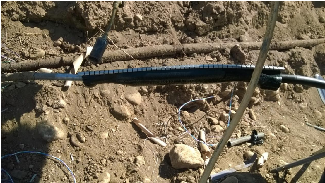
Εικόνα 54: Κόλληση χιτωνίου.
