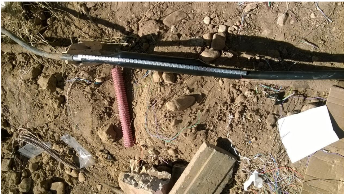
Εικόνα 55: Ολοκληρωμένη μούφα.
