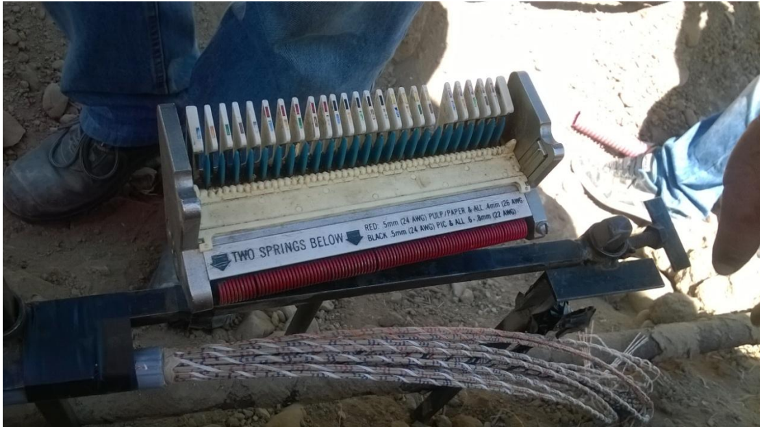
Εικόνα 37: Στερέωση καλωδίων πάνω στη μηχανή.
