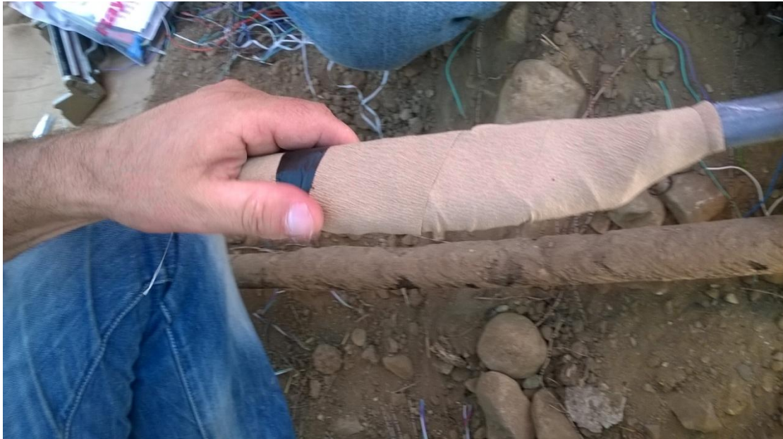
Εικόνα 46: Τυλίγμα καλώδιο με γκοφρέχαρτί.
