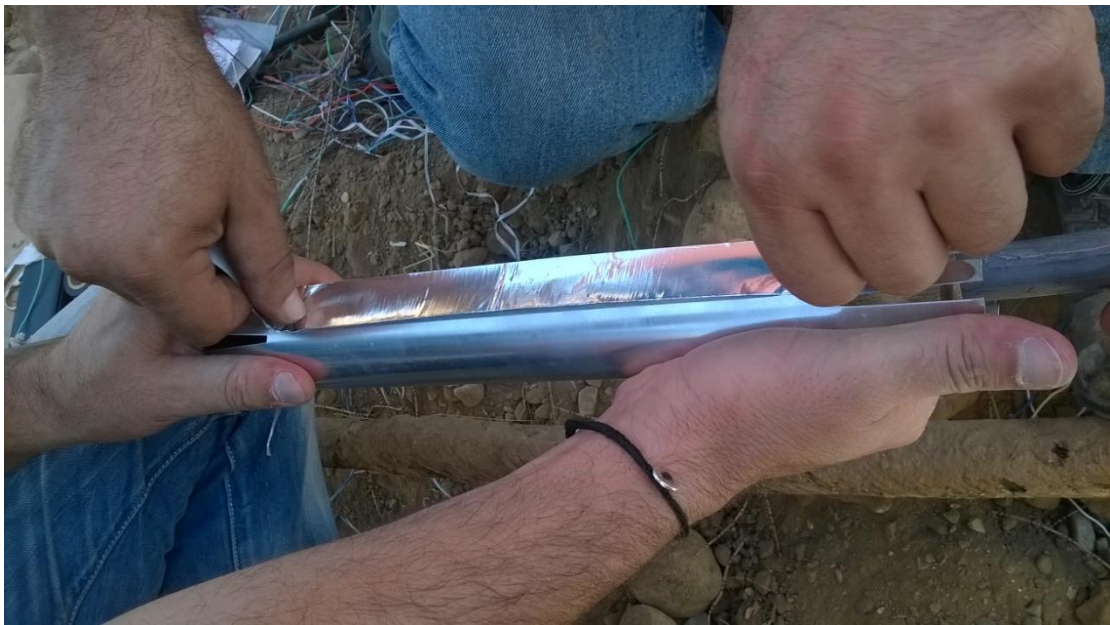
Εικόνα 47: Κόλληση αλουμινένων ταινιών.
