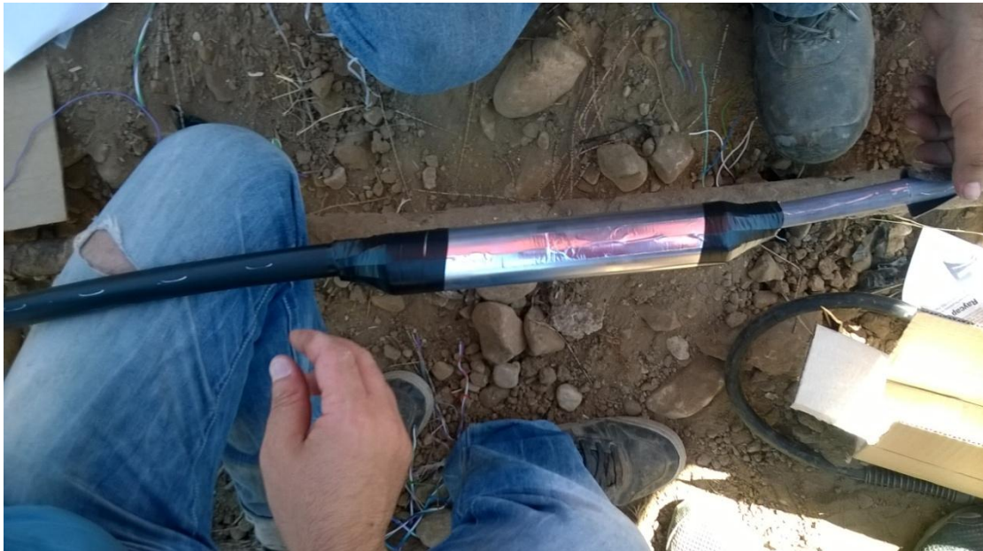
Εικόνα 49: Τύλιγμα με μονωτική ταινία.
