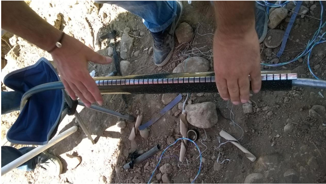
Εικόνα 52: Κεντράρισμα χιτωνίου.
