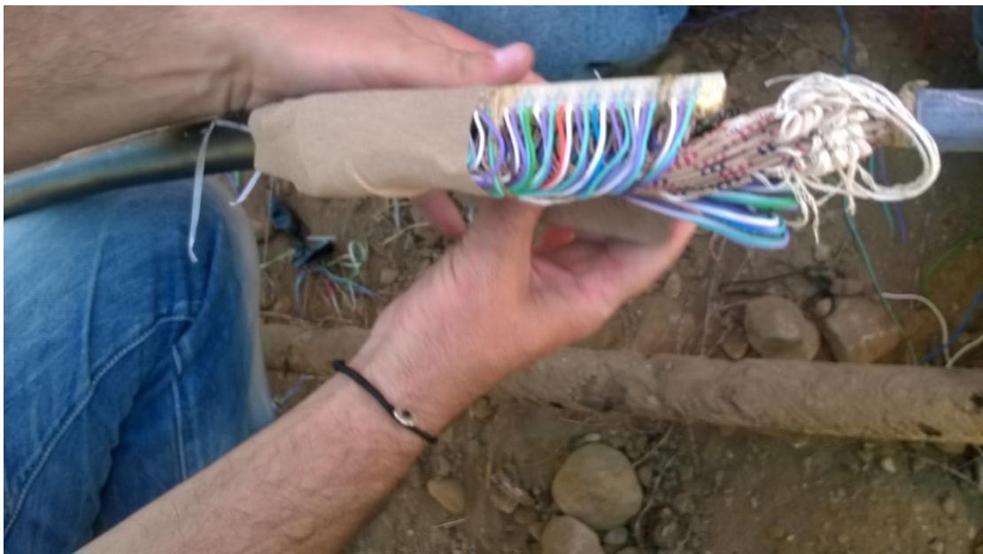
Εικόνα 45: Τύλιγμα καλωδίου με γκοφρέ χαρτί.
