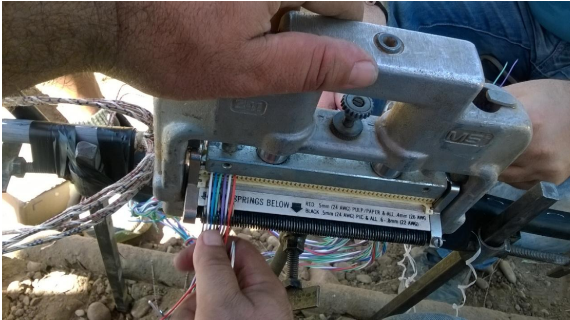
Εικόνα 43: Άκρο της υδραυλικής τρόμπας πάνω στο χτένι.
