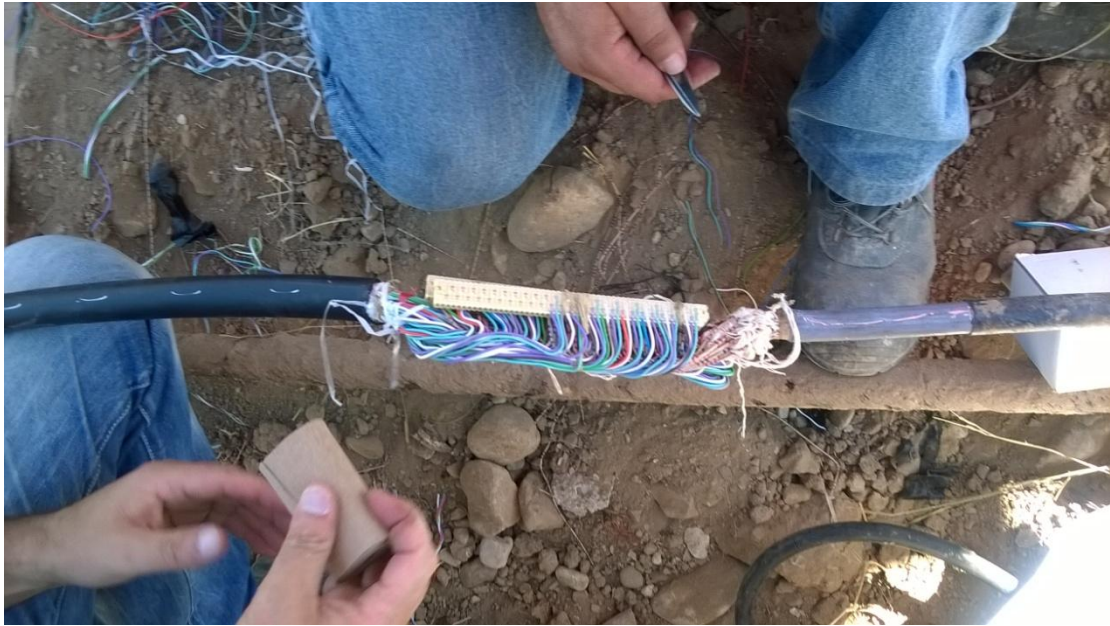
Εικόνα 44: Επιδιορθωμένο καλώδιο.
