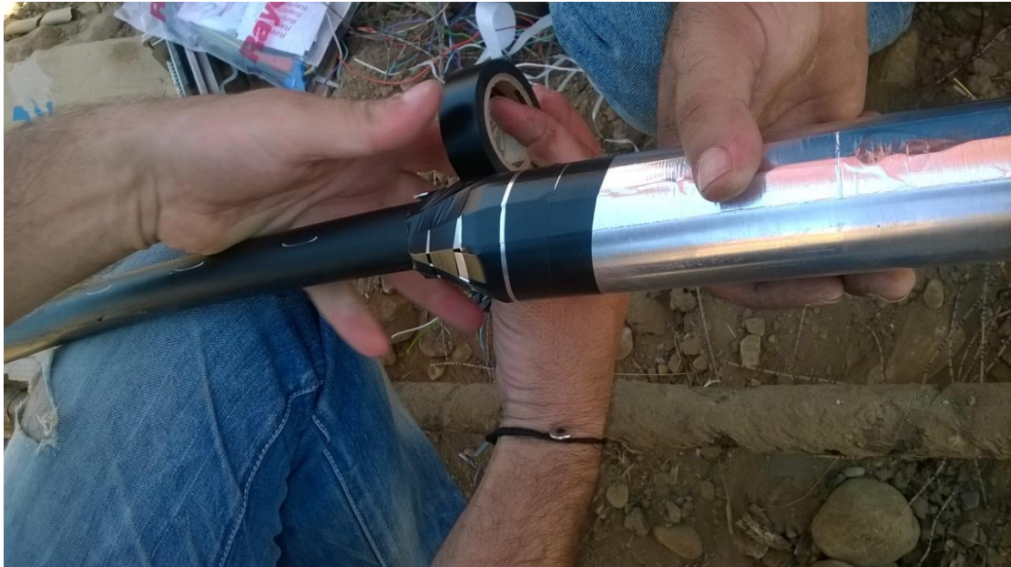
Εικόνα 48: Τύλιγμα με μονωτική ταινία.
