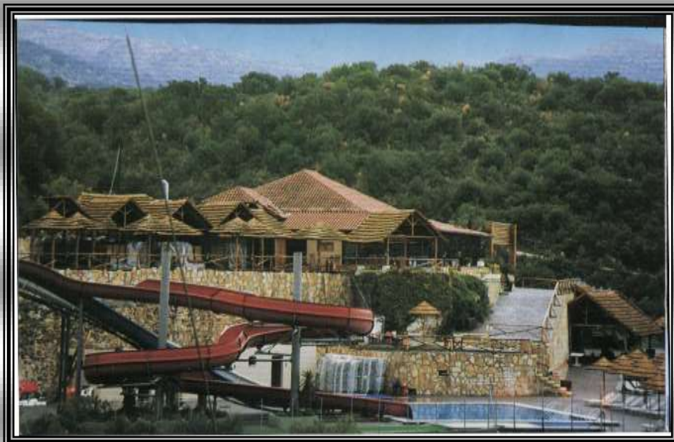
Εικ. 46 Πάρκο Ψυχαγωγίας ‘Torre a Mare’ ( Σύβοτα )
