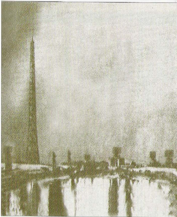
Φωτογραφία Αγγλικής ακτής του 1940 καθώς και γραμμικό σχήμα του ραντάρ "CHAIN HOME" το οποίο εγκατεστάθη στα τέλη του 1939. Αριστερά διακρίνεται ο μεταλλικός πύργος εκπομπής, ύψους 101 μέτρων (CH-RDF) καθώς και οι αλυσιδωτές κεραίες λήψης (CHL CD=Costal Defence) οι οποίες είναι τοποθετημένες πάνω σε ξύλινους πύργους ύψους 74 μέτρων, έτσι ώστε να αλλοιώνεται στο ελάχιστο το επιστρεφόμενο ανακλώμενο σήμα.
