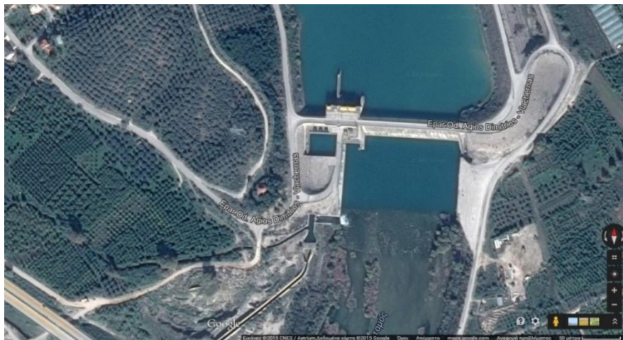
Εικόνα 4: Φράγμα ποταμού Αράχθου
