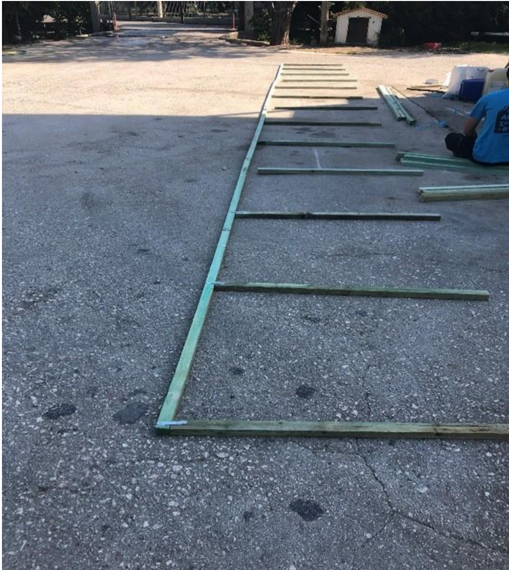
ΕΙΚΟΝΑ 25. Κατασκευή των κελιών
