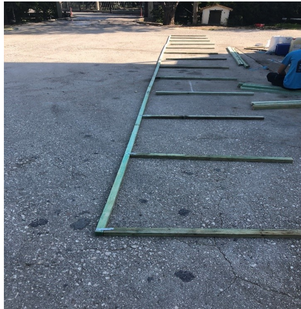
ΕΙΚΟΝΑ 58 ΚΑΤΑΣΚΕΥΗ ΚΕΛΙΩΝ
