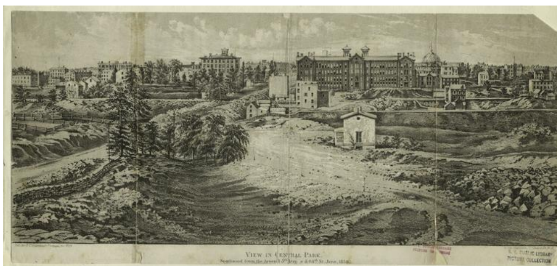
Εικόνα 3-17: Άποψη του Central Park κατά την έναρξη της κατασκευής του
