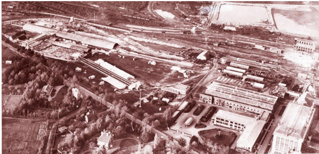
Εικόνα 3-21: Πρώην ανθρακωρυχείο Winterslag- εγκαταστάσεις επιχειρηματικού κέντρο C-mine (επάνω σήμερα και κάτω στη δεκαετία του 60) (Langer, 2019)
