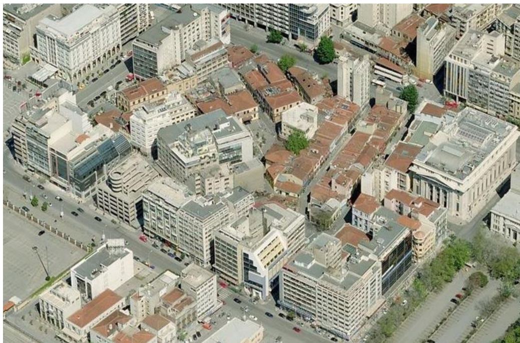
Εικόνα 5-9: Αεροφωτογραφία της περιοχής των Λαδάδικων
