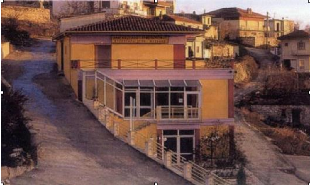
Εικόνα 4.1: Το κτήριο οπού στεγάζεται ο Αναγκαστικός Συνεταιρισμός Κροκοπαραγωγών Κοζάνης
