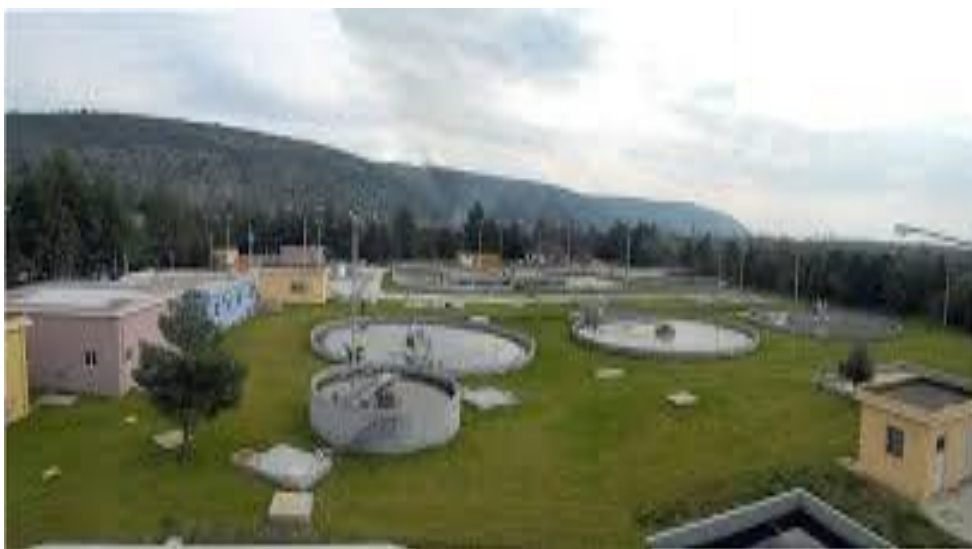
Εικόνα 1. Εγκατάσταση Επεξεργασίας Λυμάτων, Άρτα (Δ.Ε.Υ.Α.Α.)
