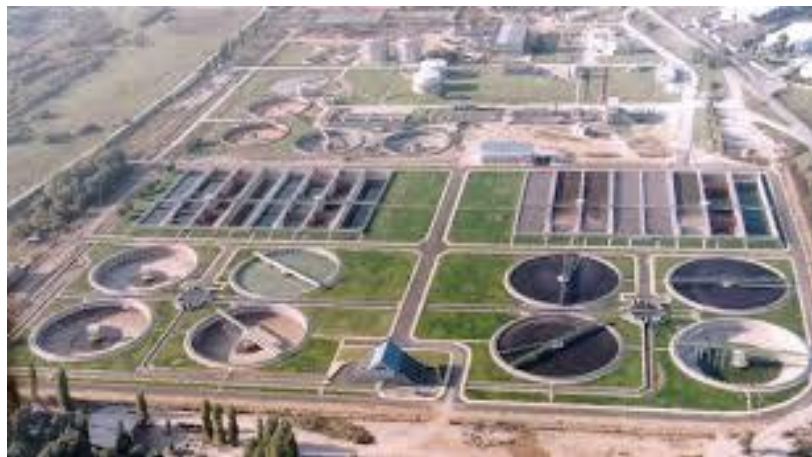
Εικόνα 2. Μονάδες επεξεργασίας λυμάτων Ψυτάλλειας και Σίνδου Θεσσαλονίκης (Ε.Υ.Δ.Α.Π., Ε.Υ.Α.Θ.)
