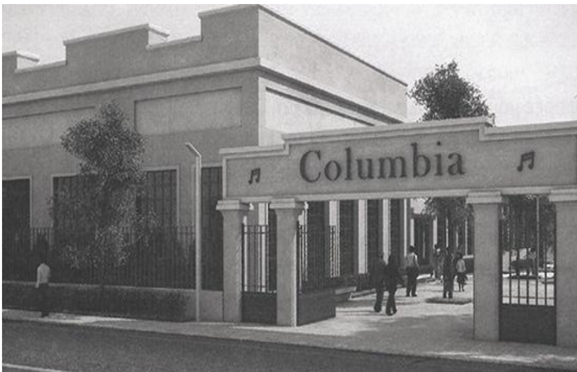
Το εργοστάσιο της Columbia στην Ριζούπολη.
