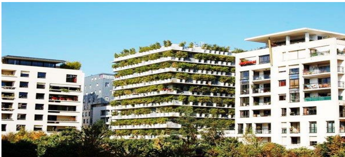
Εικ.37: Τα μπαμπού επιλέχθηκαν επειδή είναι ανθεκτικά και ταχέως αναπτυσσόμενα φυτά, αλλά και επειδή κάνουν θόρυβο στον άνεμο, δίνοντας την εντύπωση στους ενοίκους ότι κοιμούνται δίπλα σε δέντρα.
