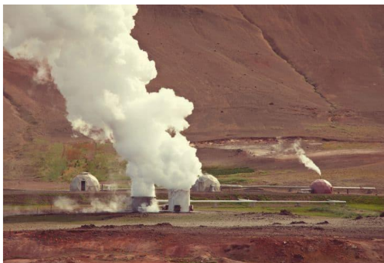
Εικόνα 2.7 Αντλίες Γεωθερμικής ενέργειας.
