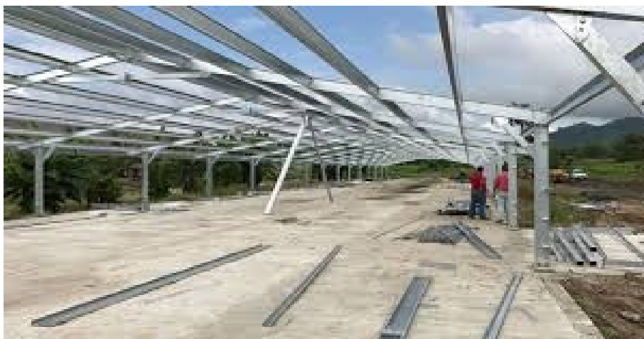
Εικόνα 19: Μεταλλικός Σκελετός Πριν την Κατασκευή Πτηνοτροφείου
