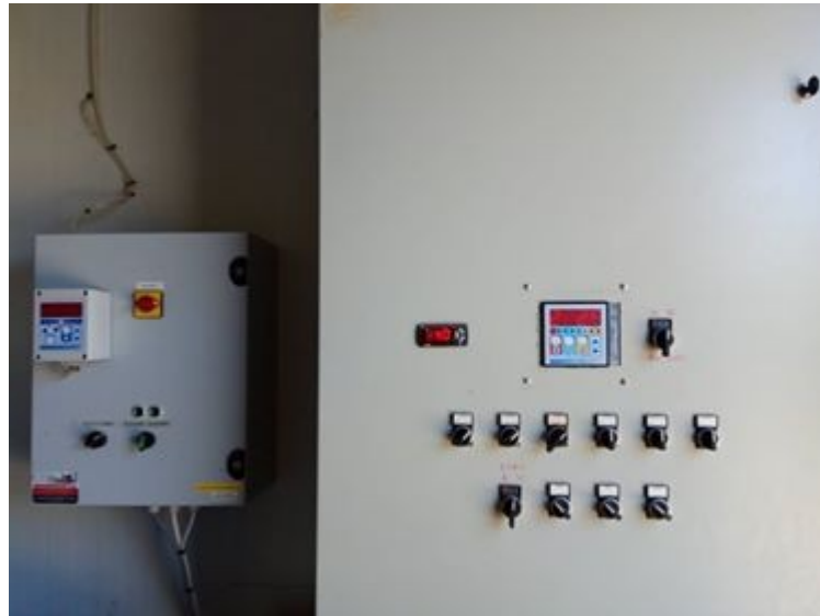
Εικόνα 21: Πίνακες Ελέγχου (Φωτισμός, Θερμοκρασία, Αέρας, Σιλό)
