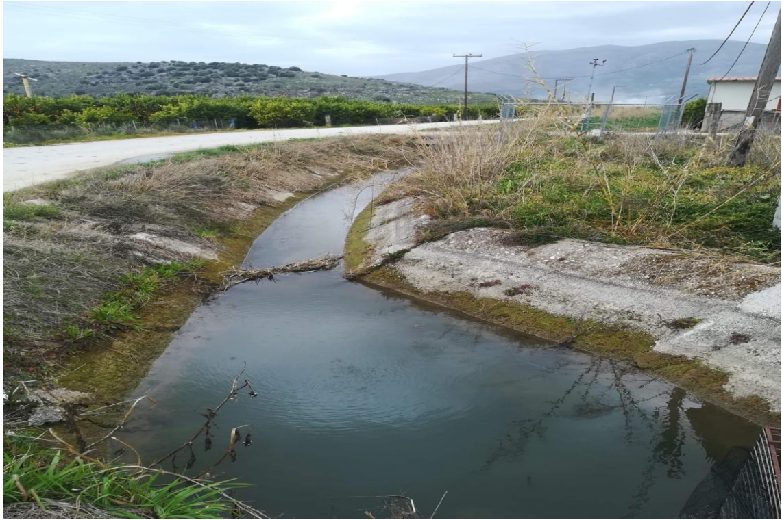
Εικόνα 24 Αρδευτικό κανάλι Ασπροκλήσιου
