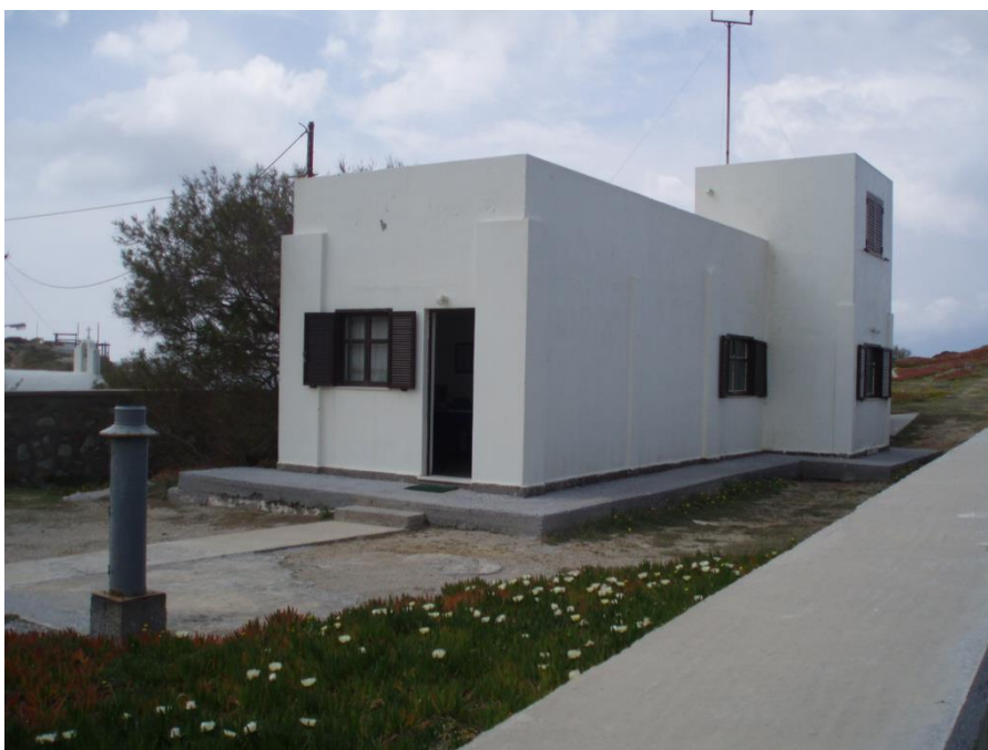
Εικόνα 1 Μετεωρολογικός σταθμός στην Νάξο
