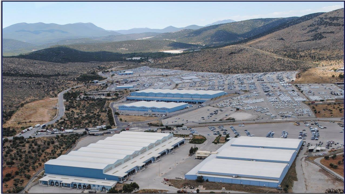
Εικόνα 5.2:Εγκαταστάσεις της ΠΑΕΓΑΕ στην Μαγούλα Αττικής. 31
