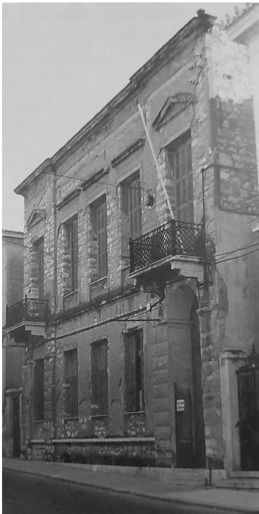
Το κτήριο της «Φιλαρμονικής» πριν ανακαινισθεί.
