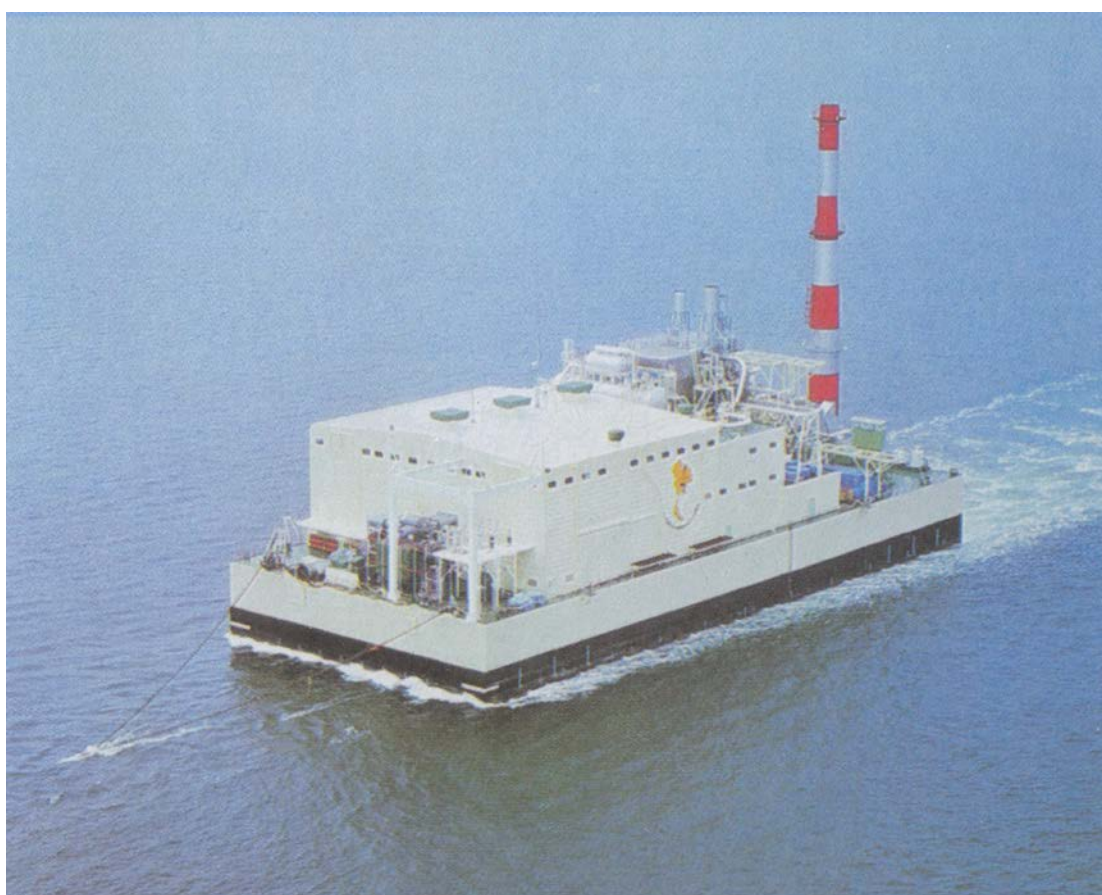
Power Plant Barge – Πλωτό Εργοστάσιο Παραγωγής Ενέργειας
