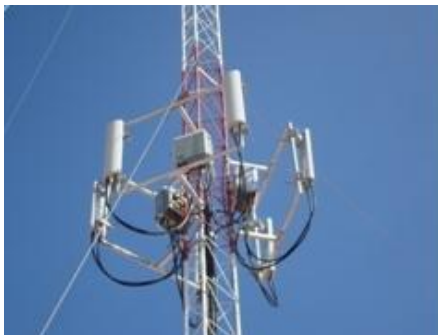
Εικόνα 3.3: Σταθμός βάσης
