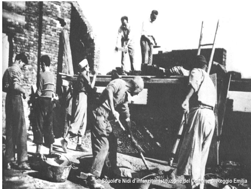
Εικόνα 1.4.1 Κάτοικοι της περιοχής συμβάλλουν στην κατασκευή σχολείου
